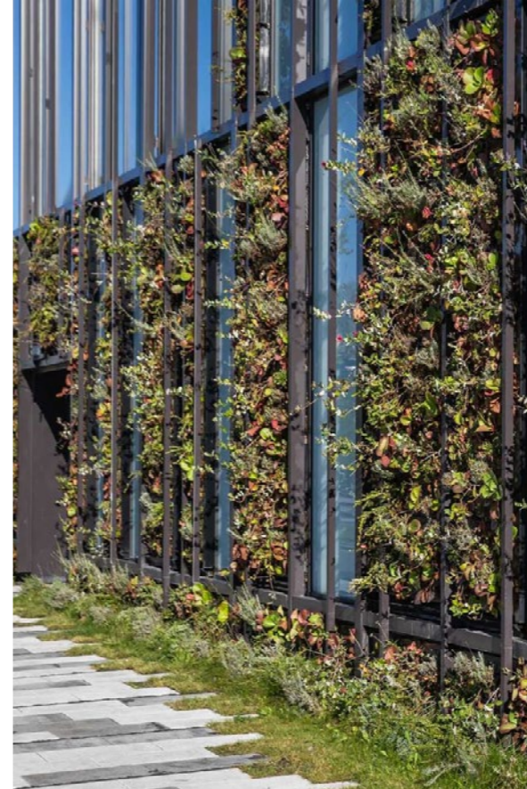
Kapková zálaha zajišťuje zalévání a je napojená na automatickou řídicí jednotku
