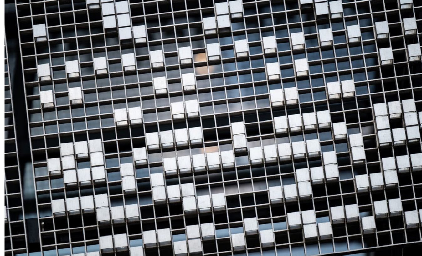
Kostičky byly umístěny do více než 2 000 hliníkových mřížek pomocí speciálního robota
