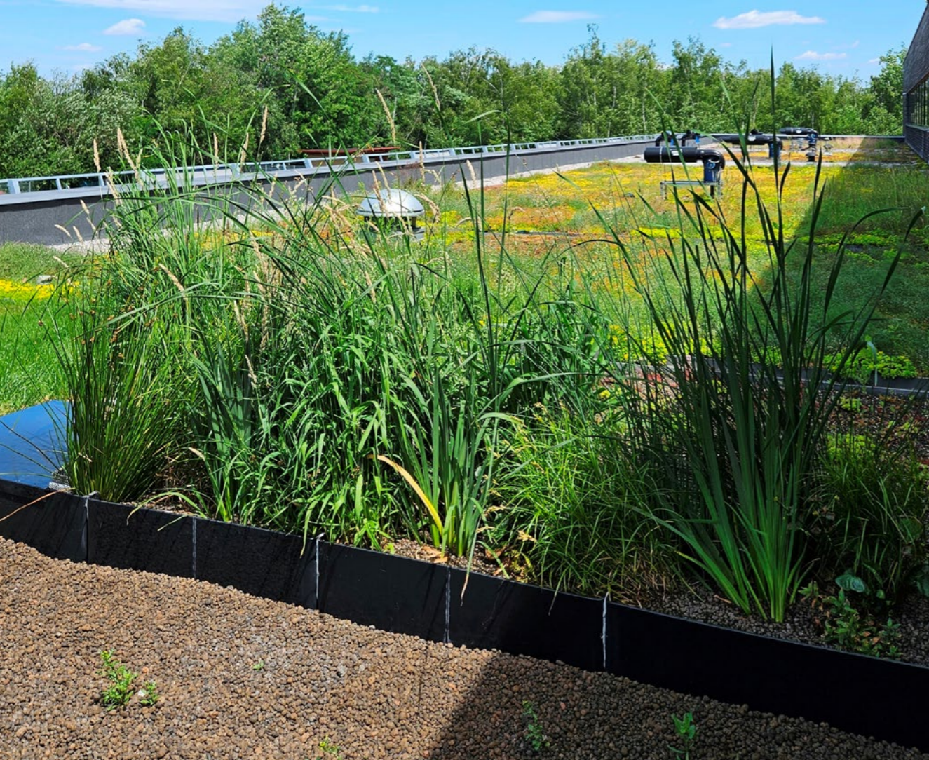
Na střeše ČVUT UCEEB jsou testovány tři různé skladby zelené střechy na stejné vrstvě minerální vaty o tloušťce 50 mm
