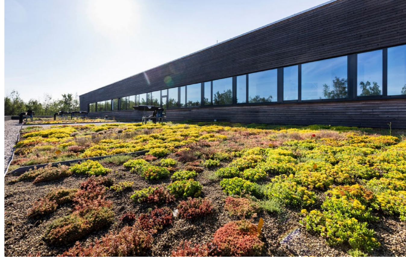
Vedle své výzkumné funkce zelená střecha poskytuje příjemný výhled z oken přilehlého open space a administrativní části budovy
